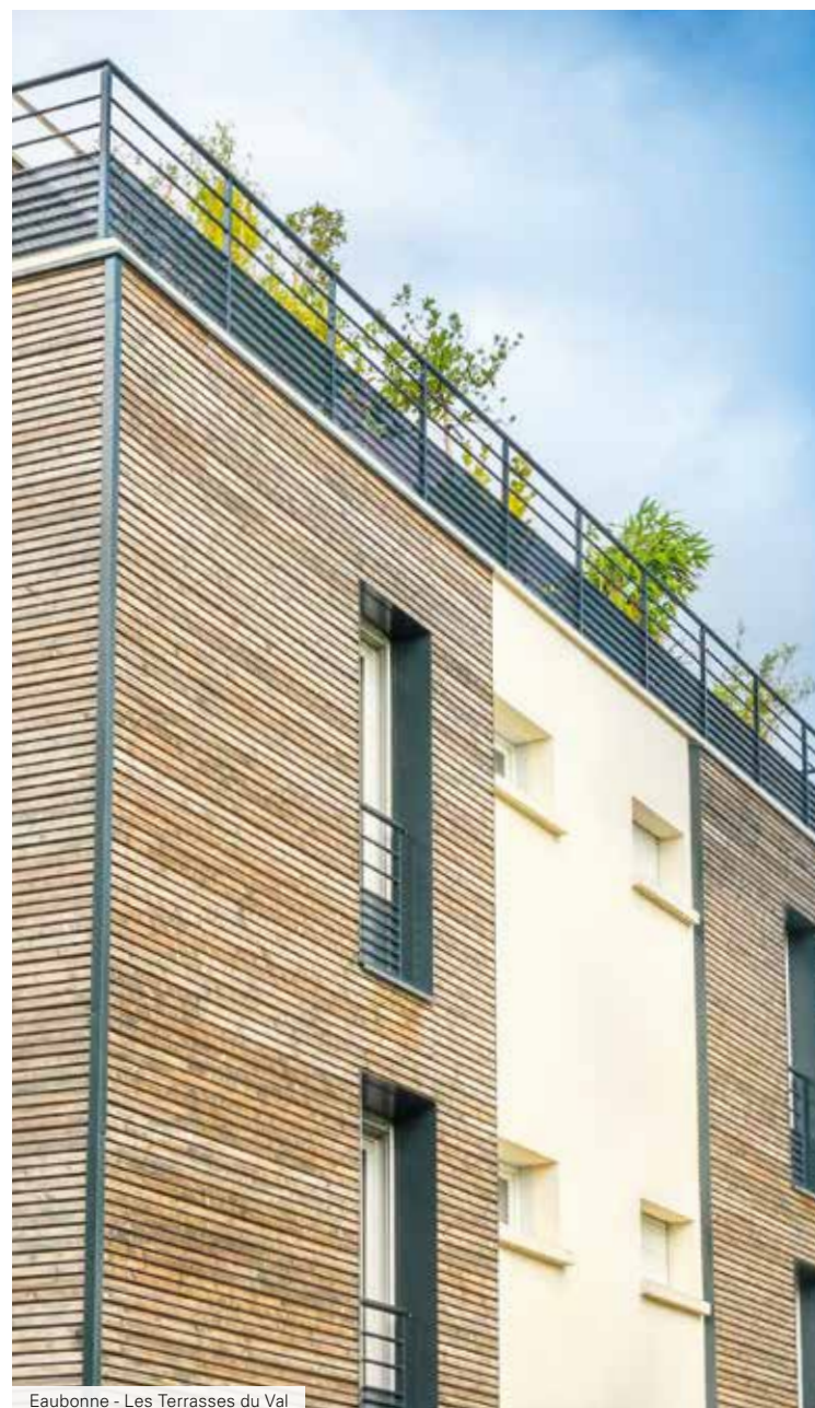
Eaubonne - Les Terrasses du Val
