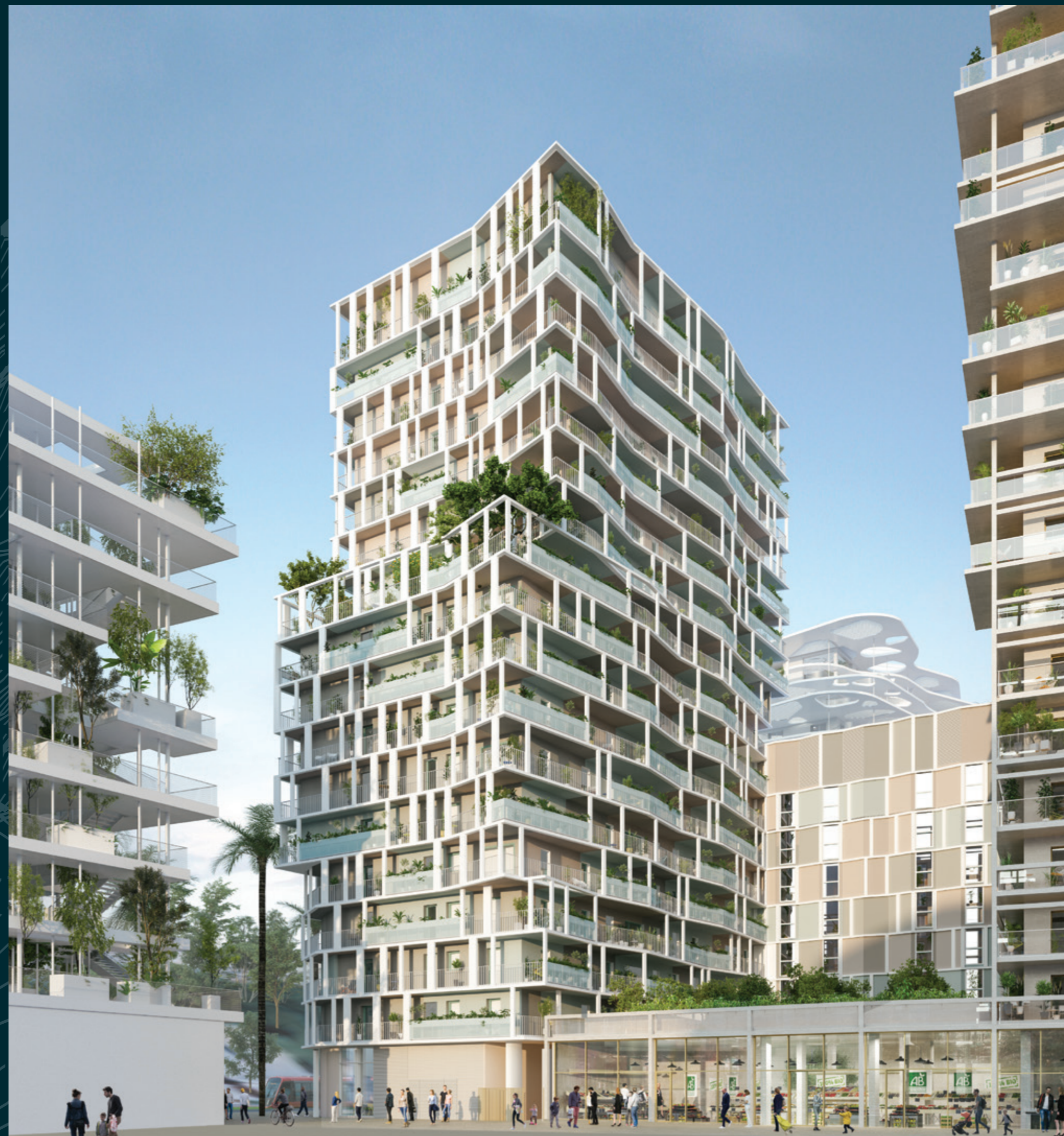
Résidence REVA, vue depuis le cours Méridia Nord
