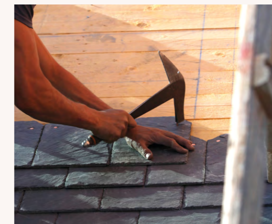
Pose des ardoises au clou au Domaine de Bonnelles, technique traditionnelle de restauration réservée aux Monuments Historiques.
