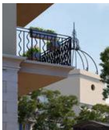
Balcons et éléments de serrurerie
