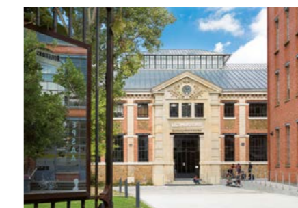
THÉÂTRE DES QUARTIERS D'IVRY - MANUFACTURE DES CEILLEYS
