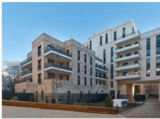
Clichy / TERRASSES EN CIEL
