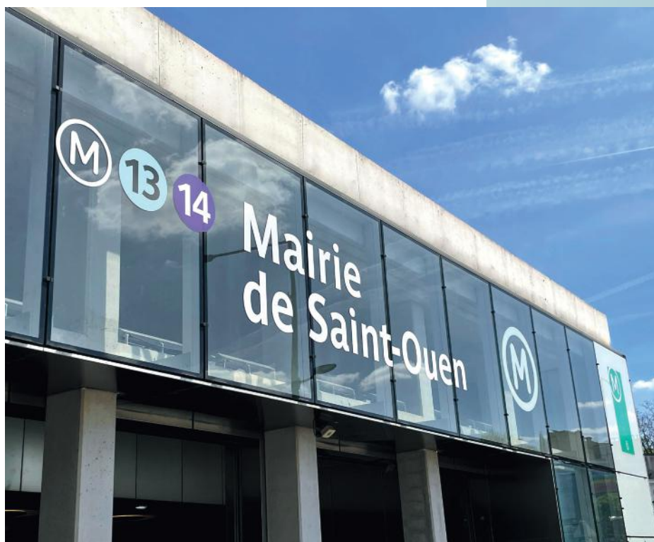
Nouvelle station de métro
