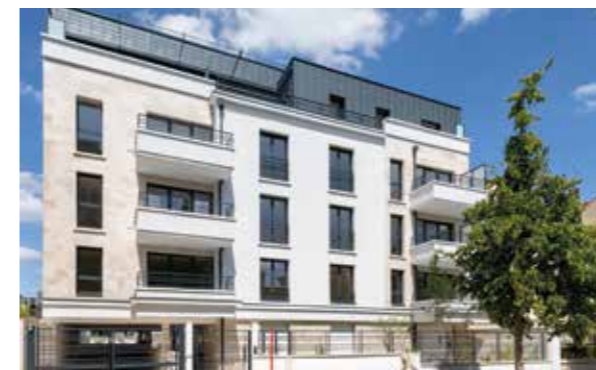
Villa Flora - Fontenay-sous-Bois Architecte : A2D Architecture
