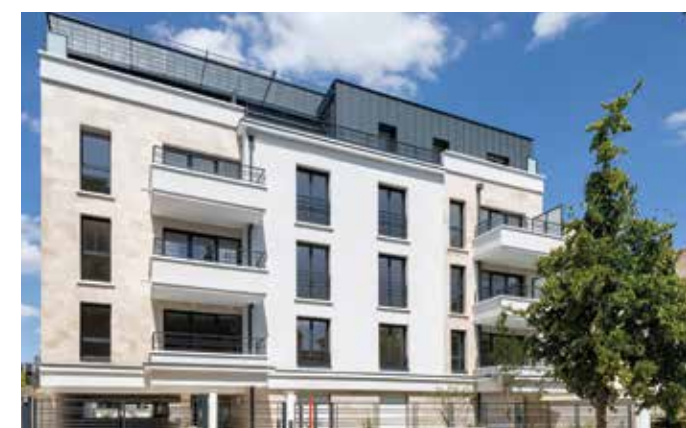
Villa Flora - Fontenay-sous-Bois Architecte : A2D Architecture
